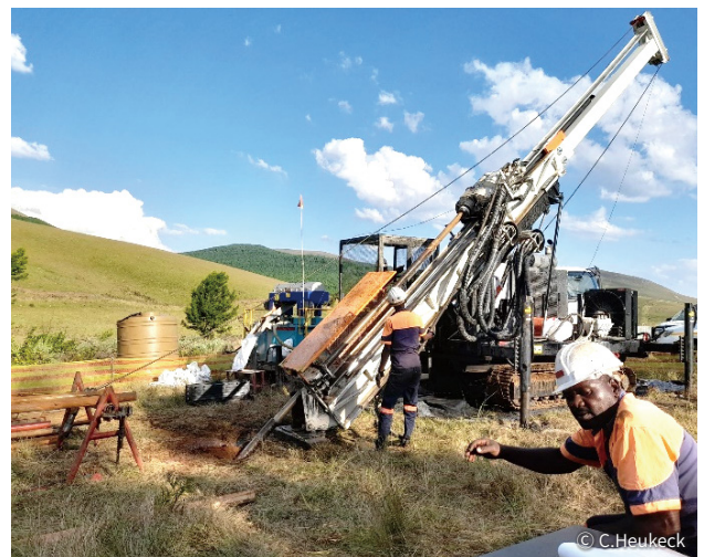
図1：バーバートン地域西部の農場の中の掘削の様子。農道しかない中をトラックが移動するのは至難の技でした。
