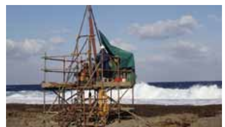
小宝島サイト2Bにおける掘削(2015年2月)
